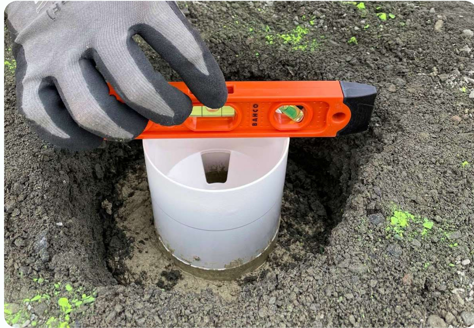
Kuva 15. Kupin suoruuden tarkastaminen vesivaakalla.
