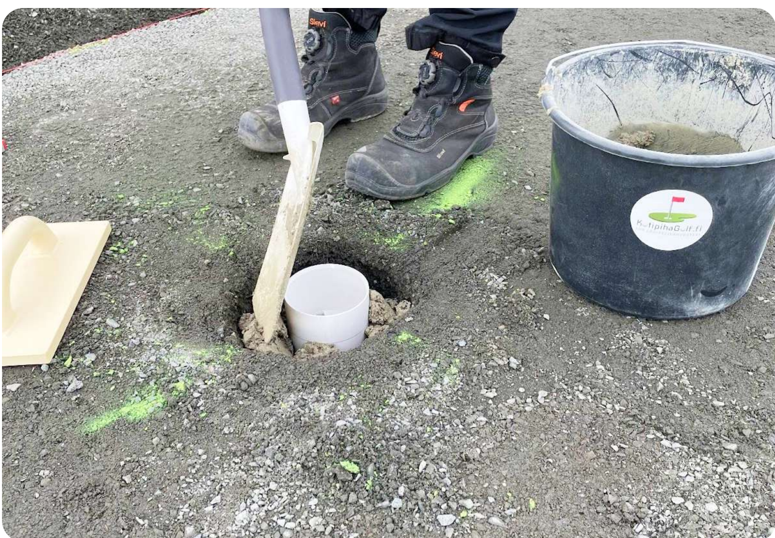
Kuva 16. Betonin lisäys kupin reunoille.
