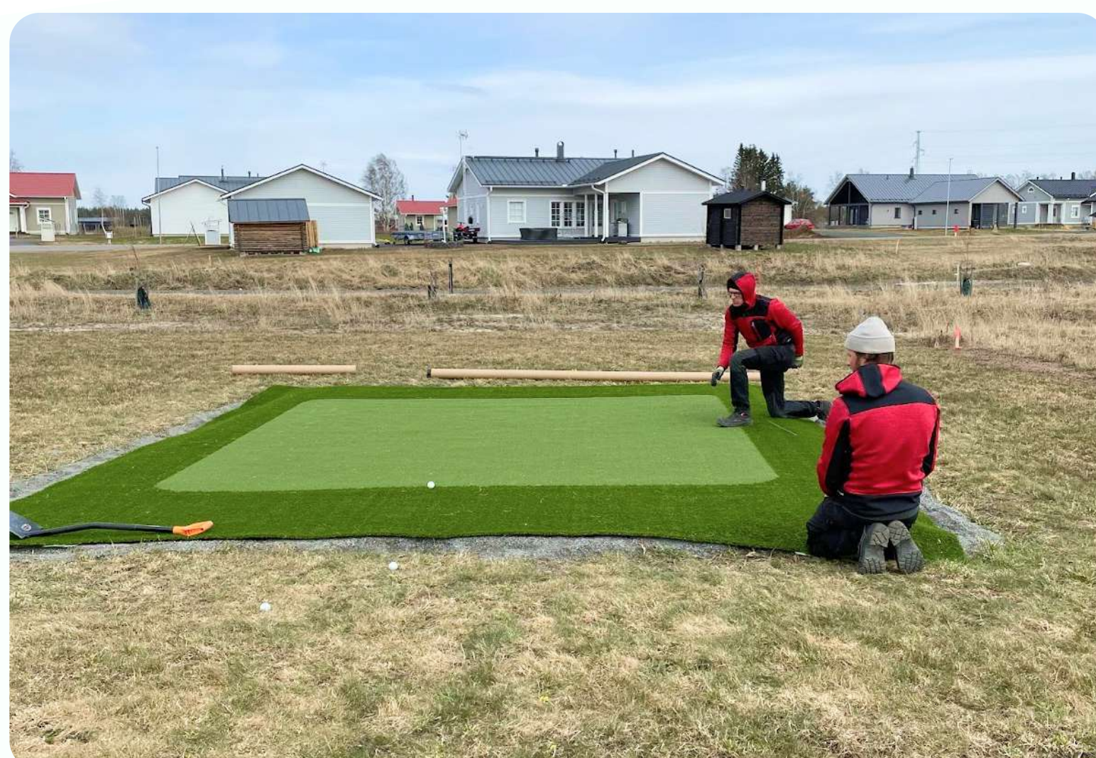
Kuva 5. Maton sovittaminen paikalleen ja haluttujen muotojen tarkistus.
