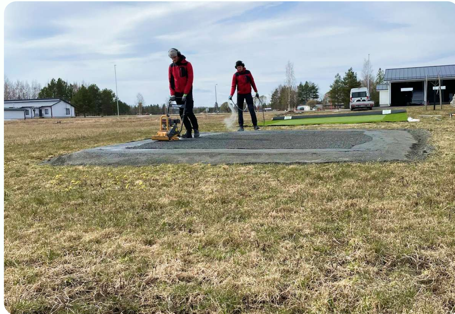
Kuva 3. Kostean kivituhkapinnan lätkeäminen tiiviiksi.
