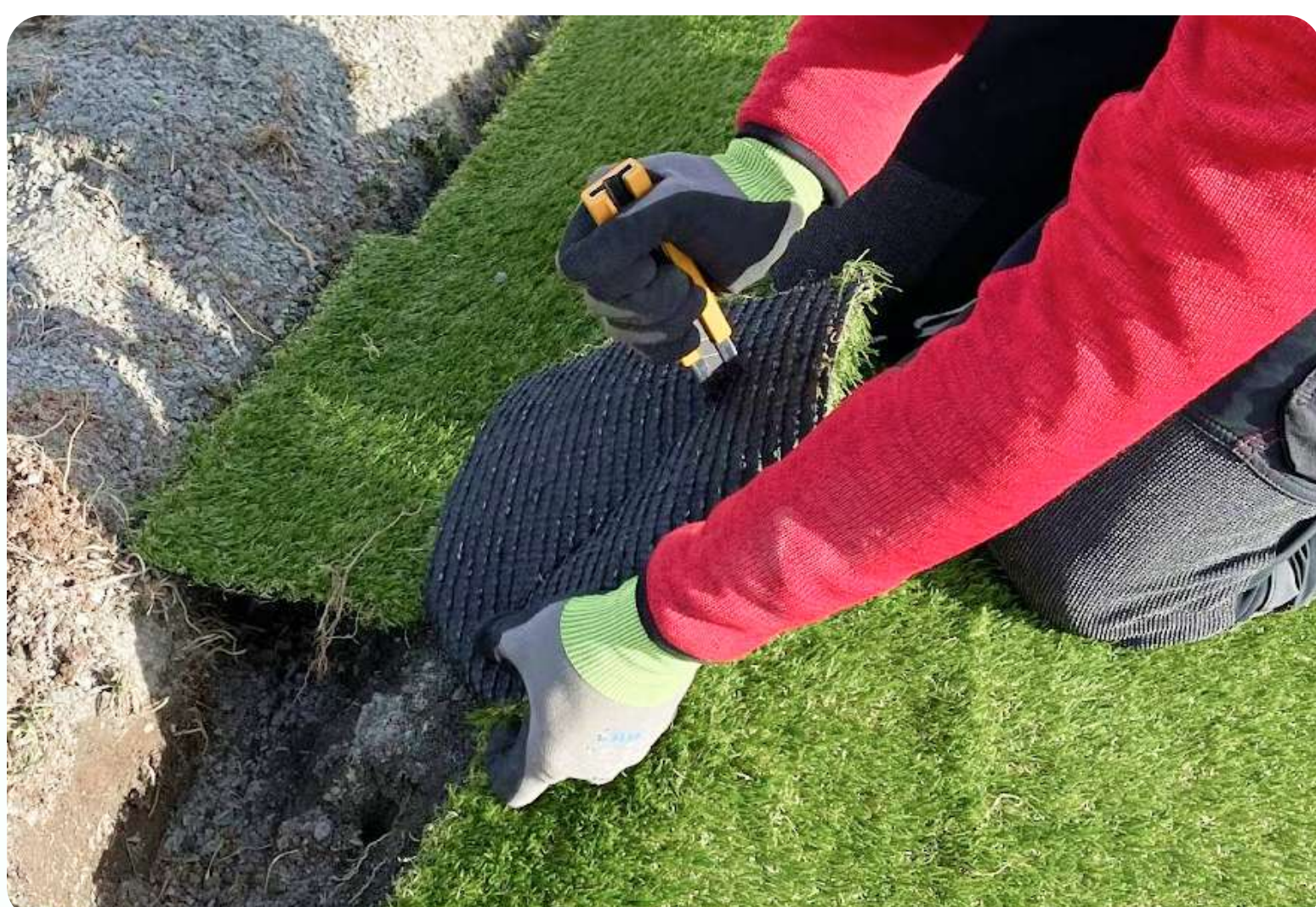
Kuva 21. Greenimaton kulmien leikkaaminen.
