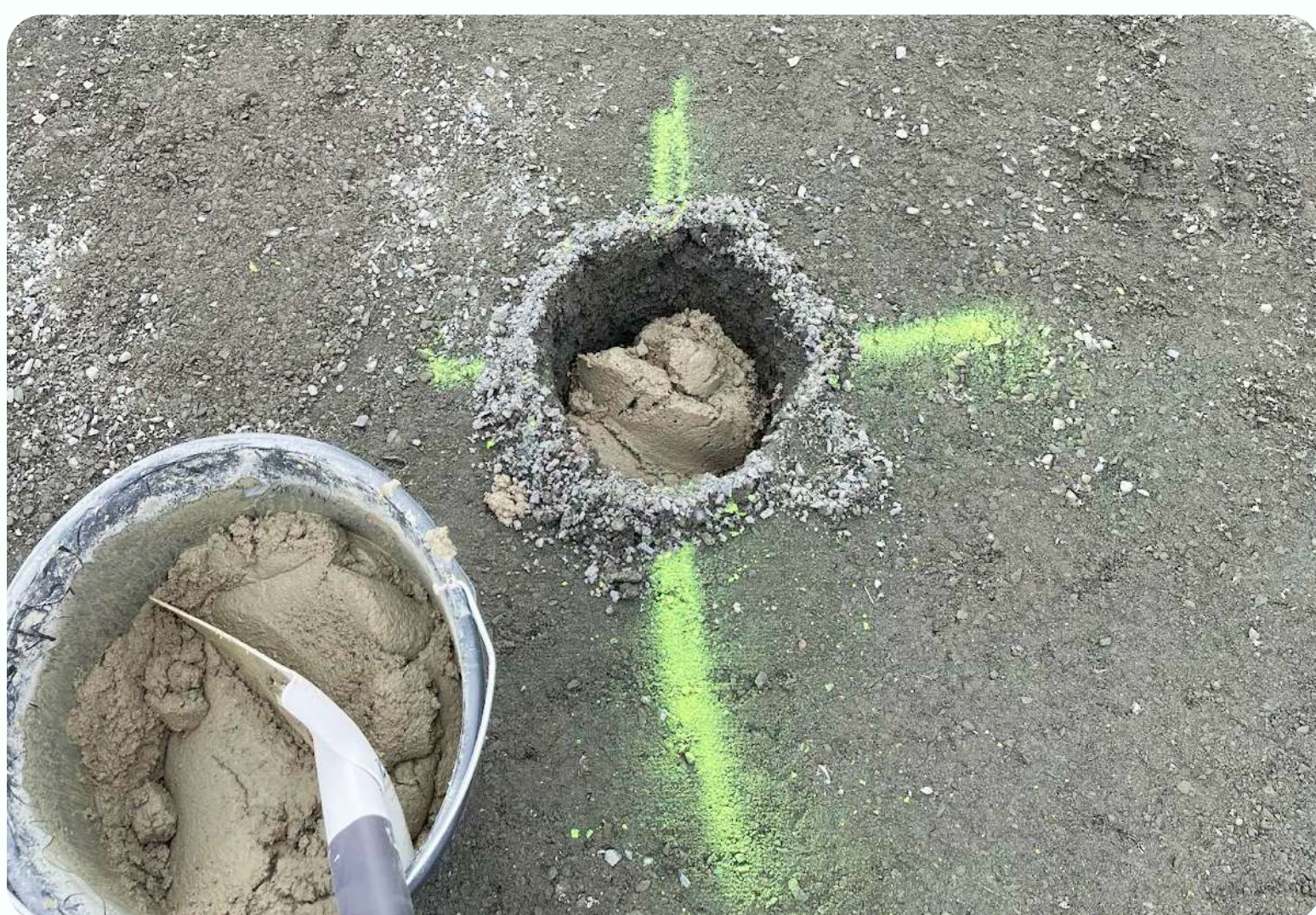
Kuva 12. Betonin laittaminen reiän pohjalle.
