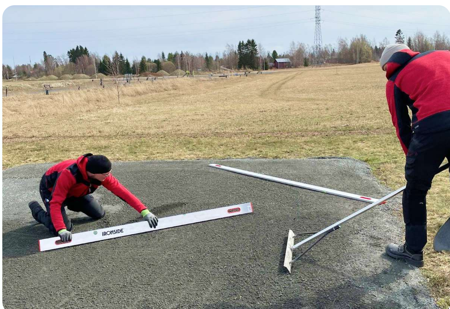
Kuva 4. Kivituhkapinnan viimeistely oikeaan muotoon.
