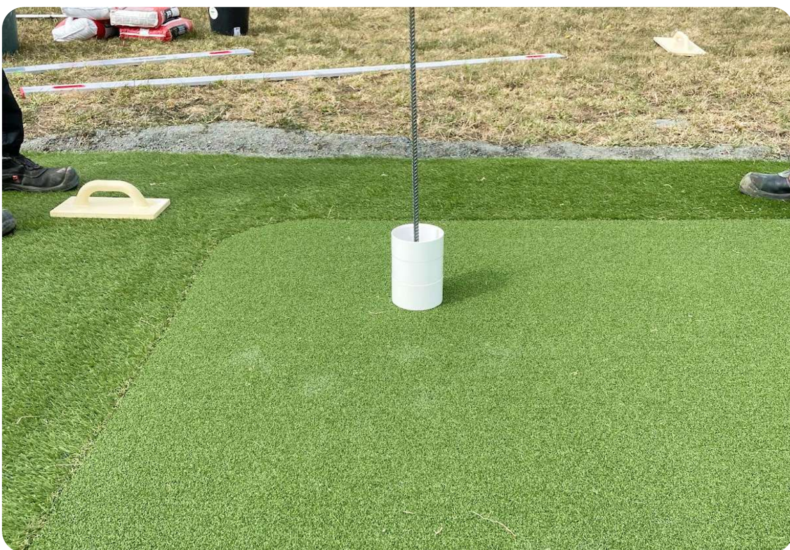
Kuva 6. Reikien paikan merkkäminen.
