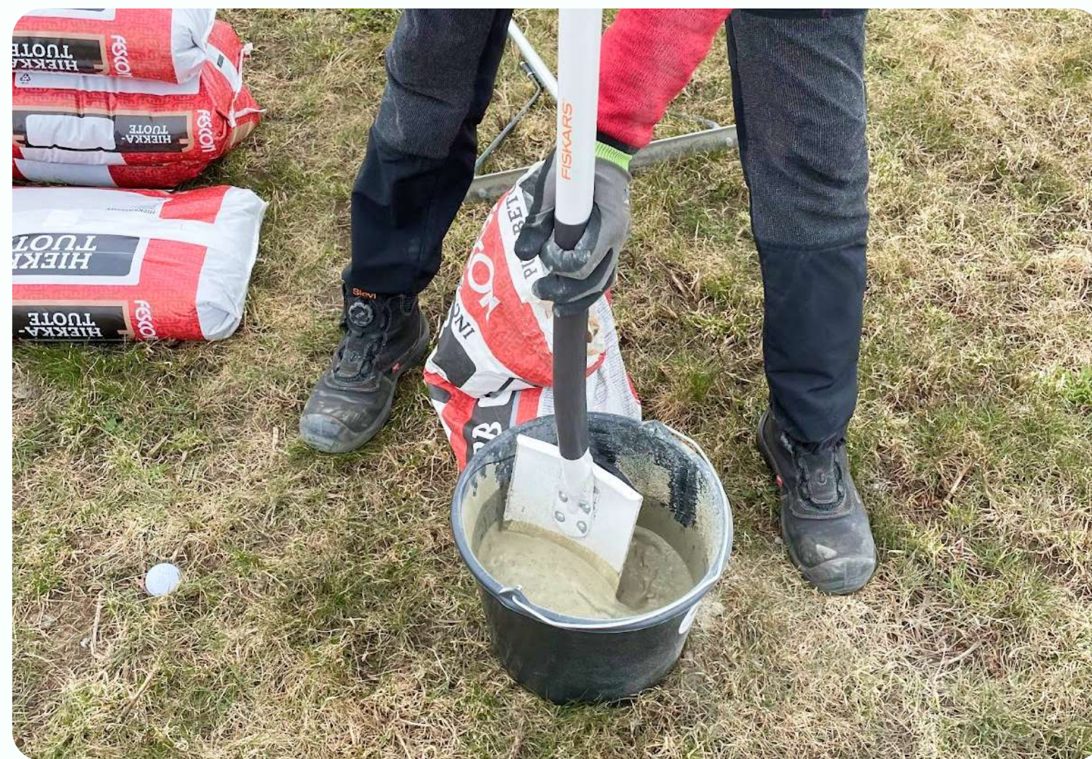
Kuva 11. Valmisbetonin sekoitus.
