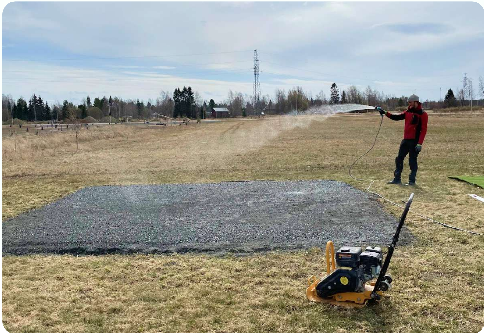
Kuva 2. Kivituhkapinnan kastelu sumuttamalla.
