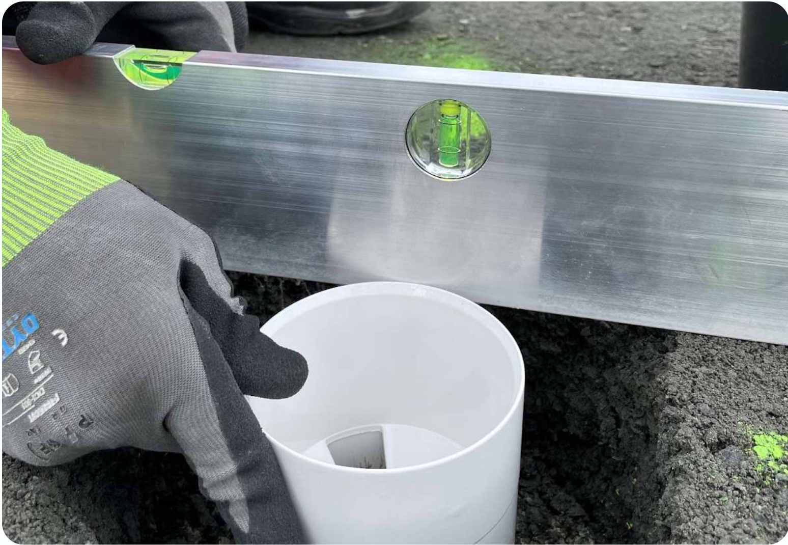
Kuva 14. Kupin asentaminen 5 mm kivituhkapinnan yläpuolelle.
